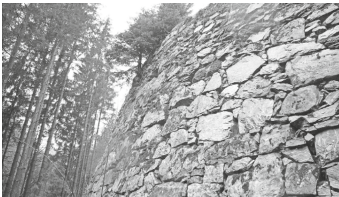
Die Stützmauer an der L 126 bei Oberried. Foto: RPF
