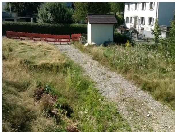
Abbildung 6: Trafohäuschen im südwestlichen Bereich, rechts der Gewässerrandstreifen.
